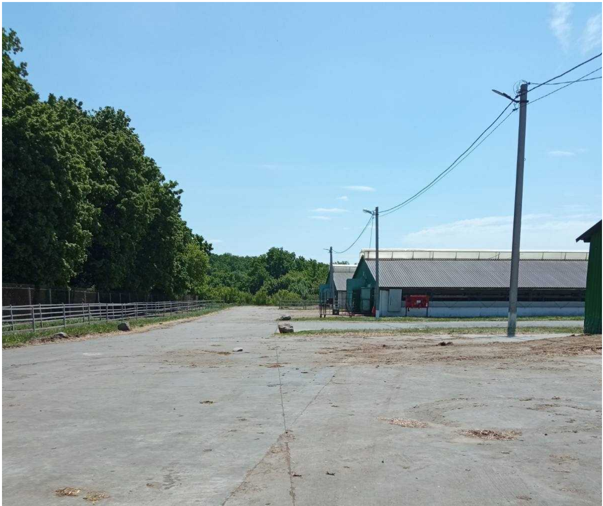
Рис. 3.1. Територія ферми з бетонованим покриттям
