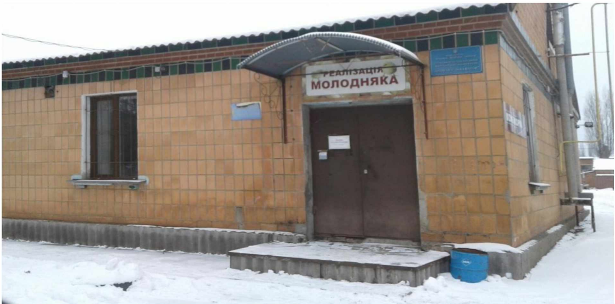
Рис. 3.1. Приміщення СВК «Полтава-інкубатор»
