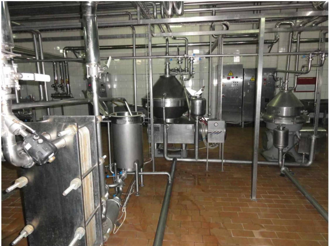
Рис. 3.3. Обладнання апаратного цеху (сепаратори)
