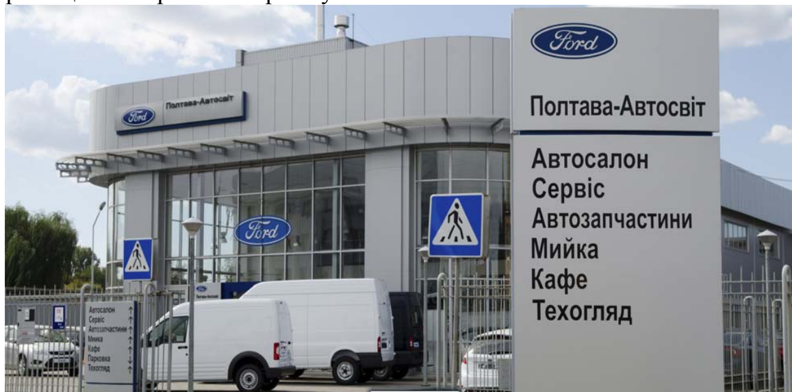
Рис. 2. Оздоблення фасаду приміщення ТОВ «ДК «Полтава-Автосвіт», 2018 р.
