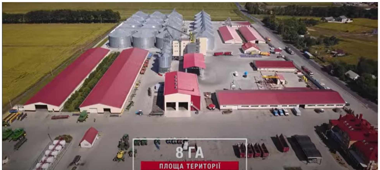
Рис. 2.2. Загальний вигляд комплексу
