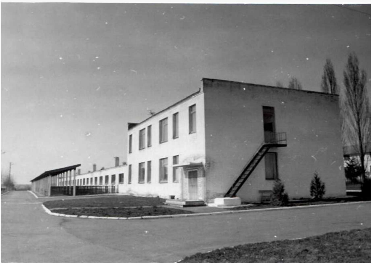
Рис.2.1. Зовнішній вигляд елеверу
