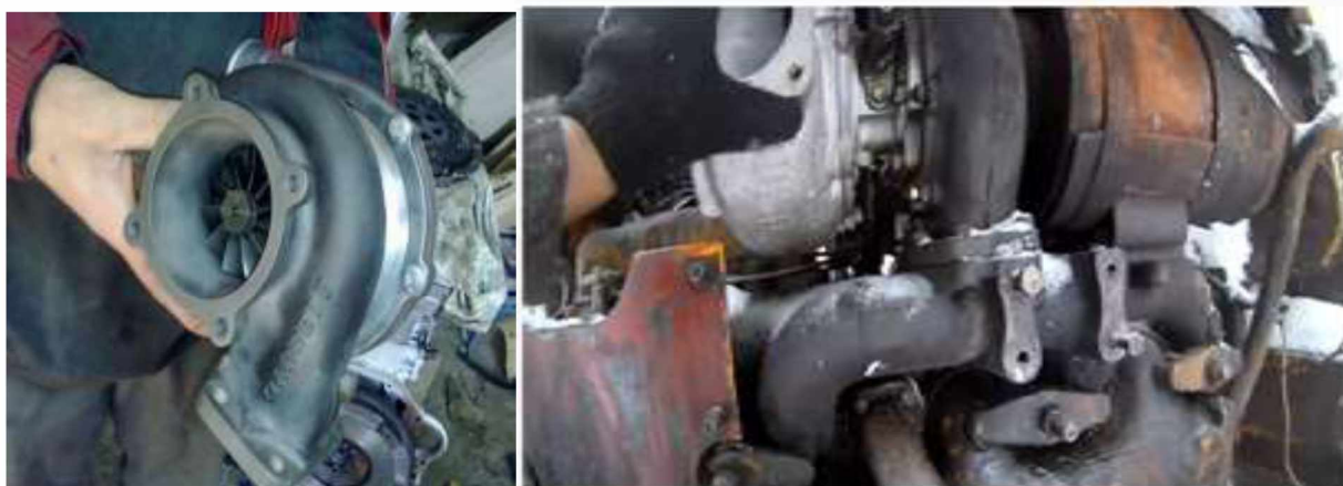
Рисунок 3.10 – Встановлення турбокомпресора на трактор
