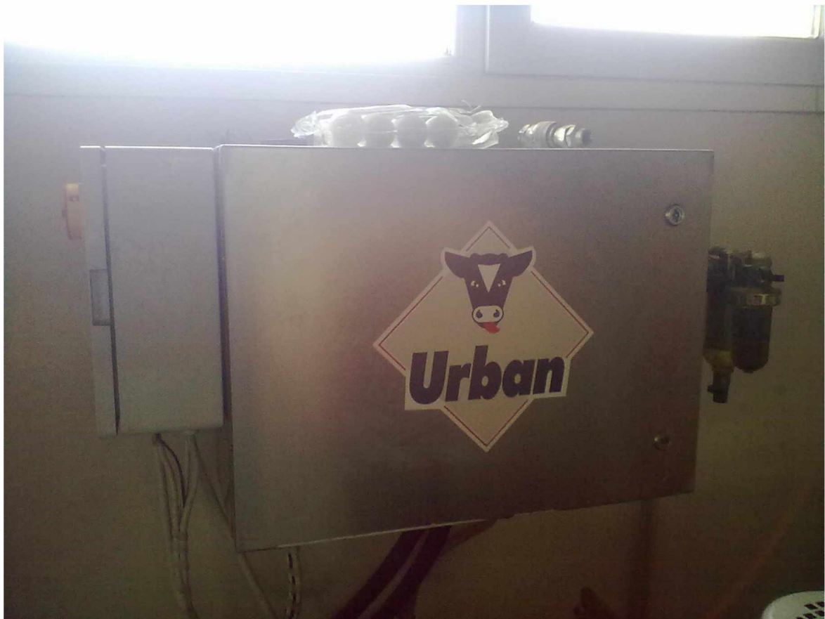
Рис. 3.6. Електронний блок управління і нагріву води
