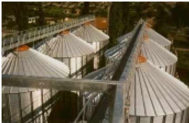
Рисунок 1.8 – Силосні корпуси з оцинкованої сталі
