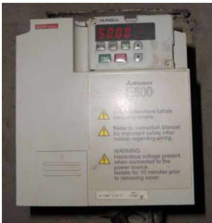
Рисунок 2.3 – Перетворювач частоти електричного струму FR-E540-0.4K-7.5K(FC)
