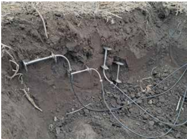
Рис. 3. Встановлені датчики вертикальної деформації
