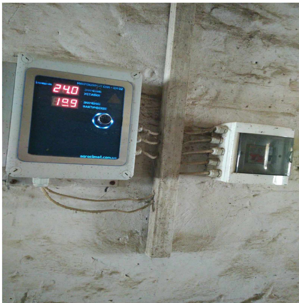
Рис 3.7. Датчики реєстрації параметрів мікроклімату.
