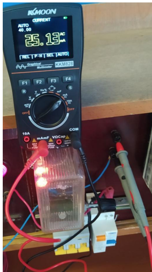
Рисунок 1 – Загальний вигляд стенду для перевірки струмів спрацювання ПЗВ
