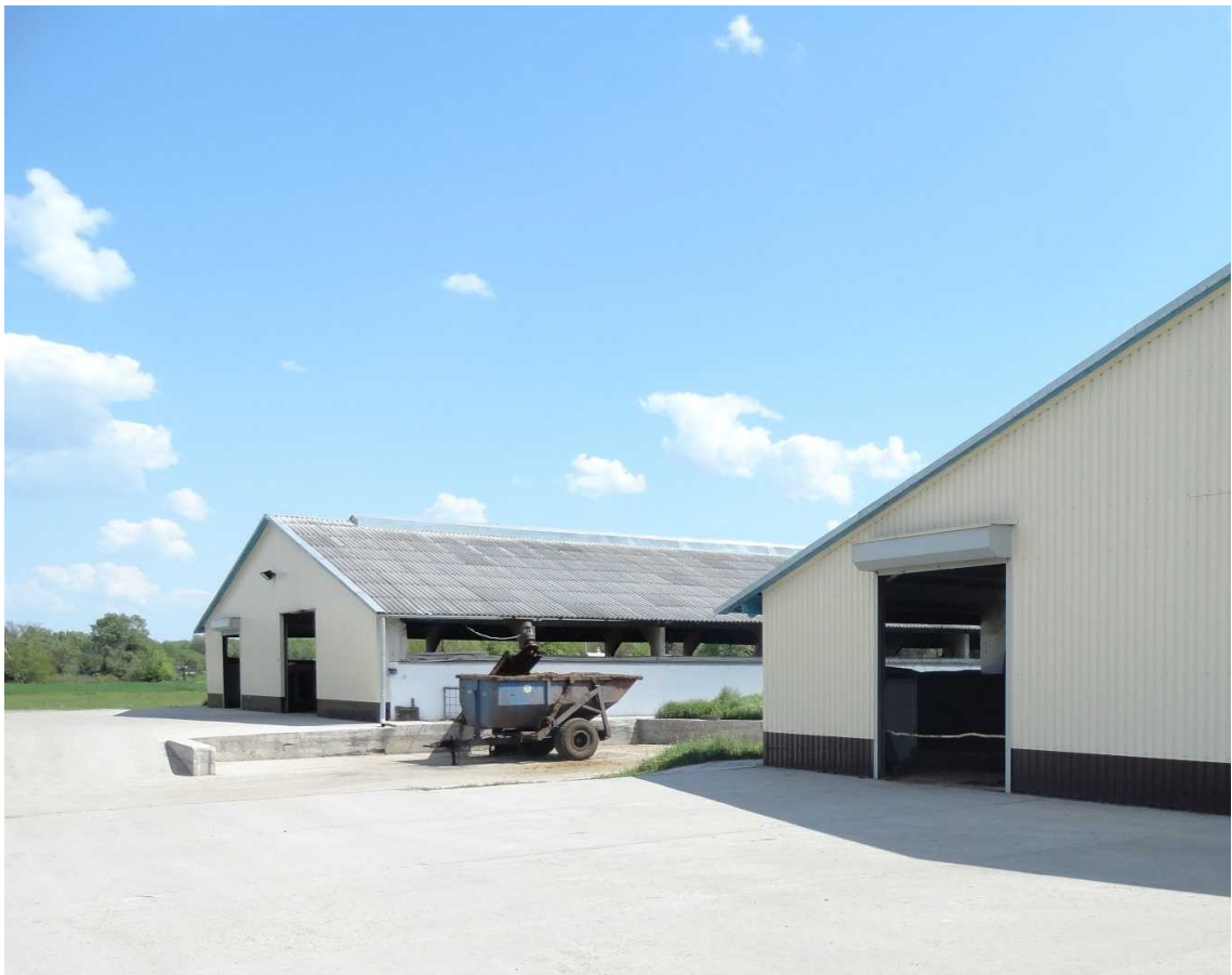
Рис. 3.8. Видалення гною з приміщення корівника
