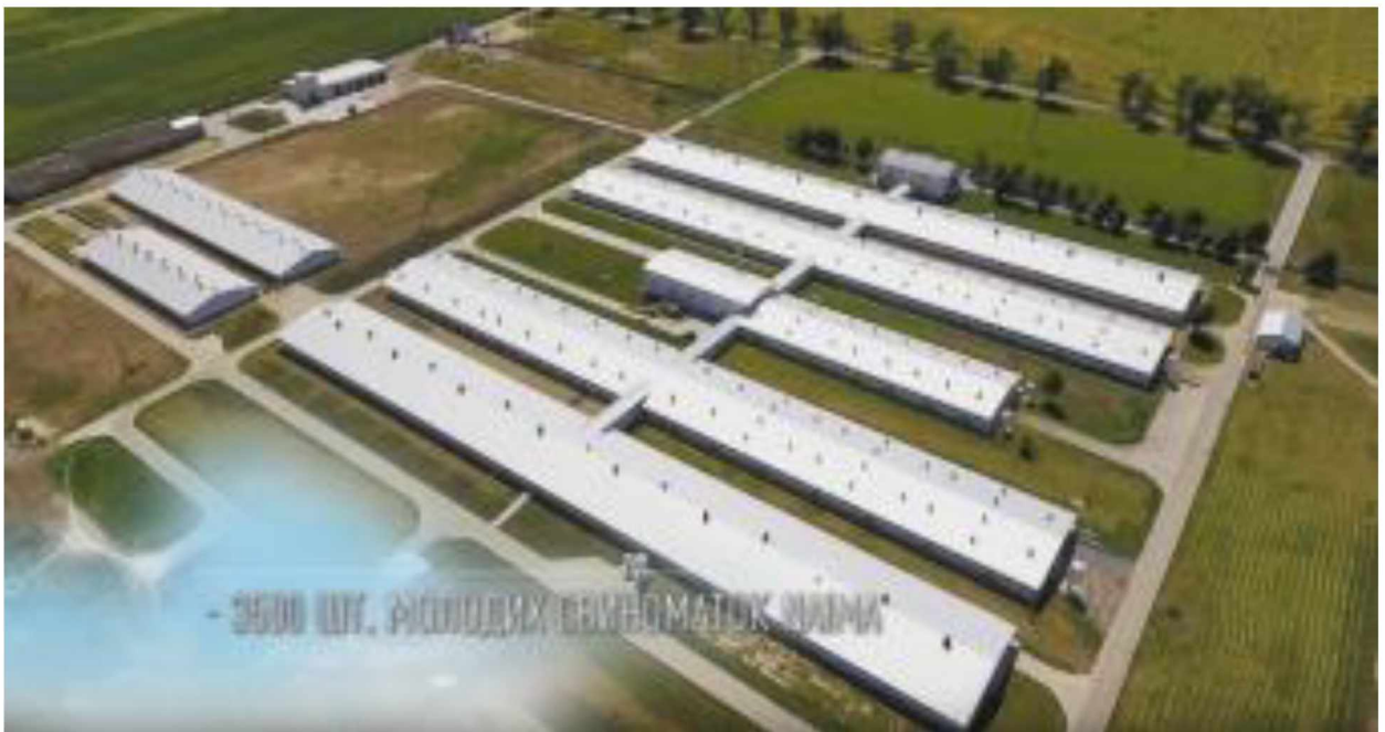
Рис. 1. Загальний вигляд комплексу
