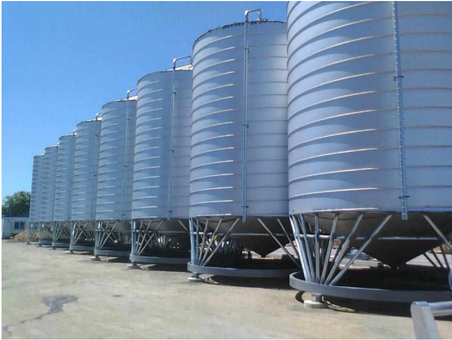
Рисунок 1.5 – Варіанти конструктивного виконання днищ силосів
