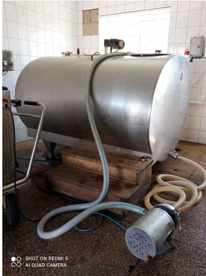
Рис. 3.10. Резервуар для зберігання молока
