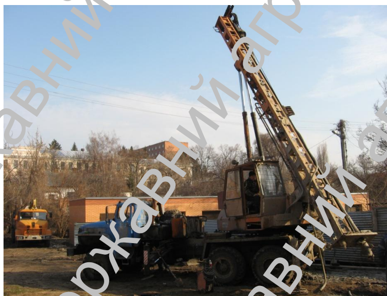
Рисунок 1 – Дослідні виготовлення ґрунтоцементних палів
