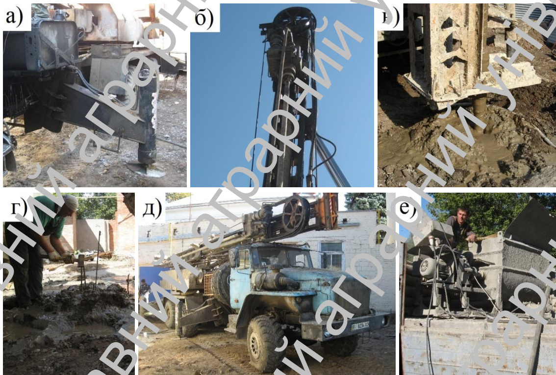
Рисунок 2 – Складові процесу: а) вивезення опор, б) установлення бура в необхідне положення, в) буріння, г) забивання арматури, д) переїзд на наступну стоянку, е) подача цементного розчину.
