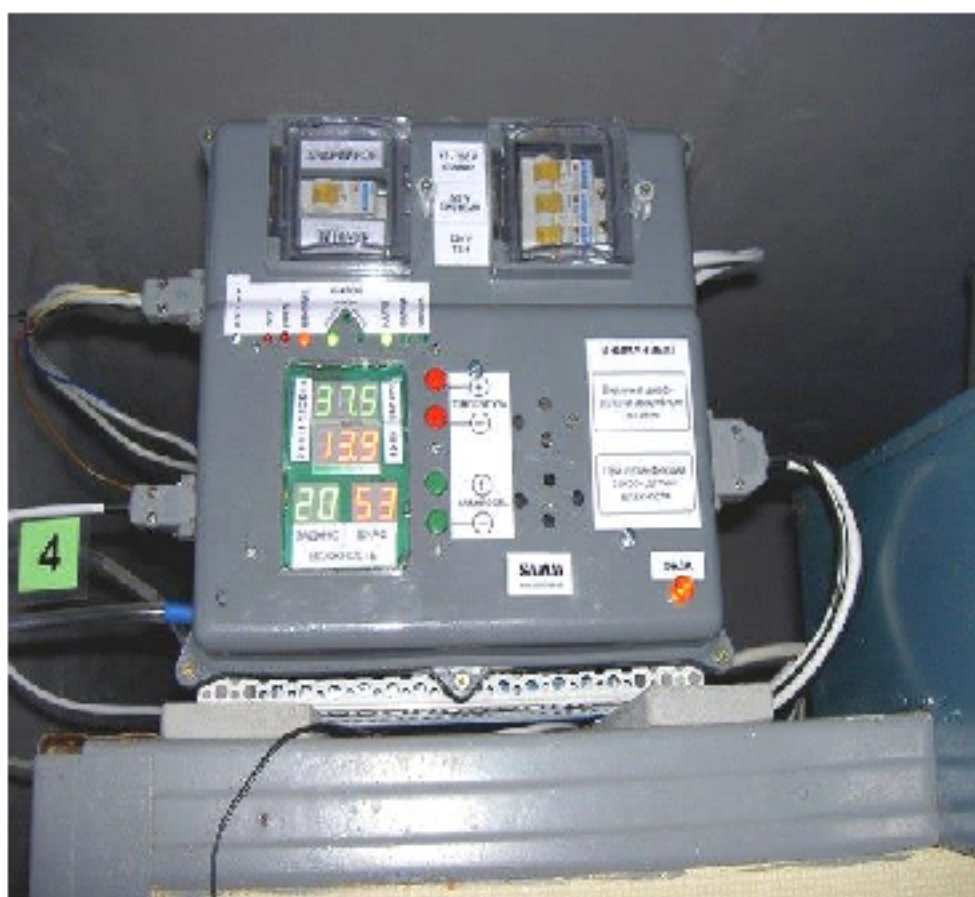
Рис. 3.2. Блок управління встановлене на інкубаційному шафі
