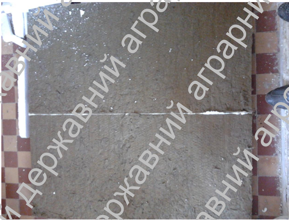
Рис. 3.1 Склеювання мінераловатних плит між собою
