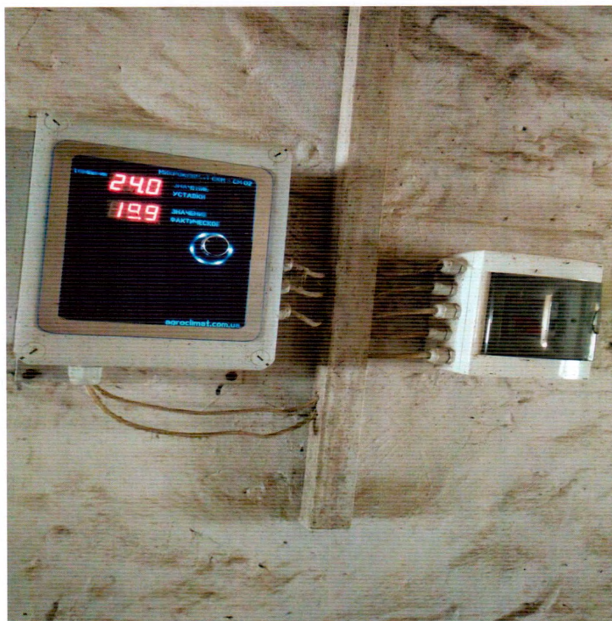
Рис 3.7. Датчики реєстрації параметрів мікроклімату.
