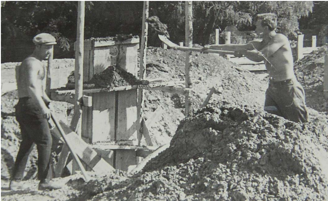
На будівництві корпусу №3 студенти набувають нових навичок, що не завадять у подальшому житті
