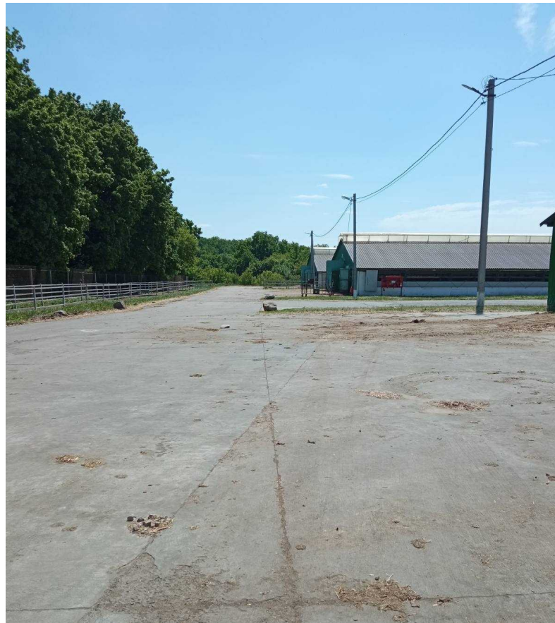
Рис. 3.1. Територія ферми з бетонованим покриттям
